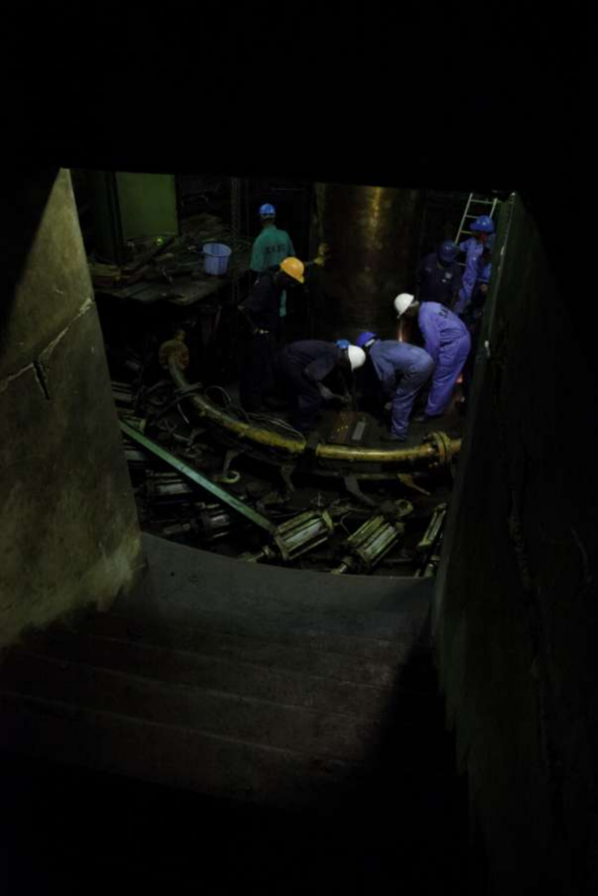
Les Agents à la centrale d'Inga e plein travail de réhabilitation
