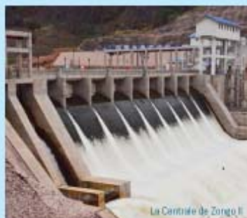
La Centrale de Zongo II
